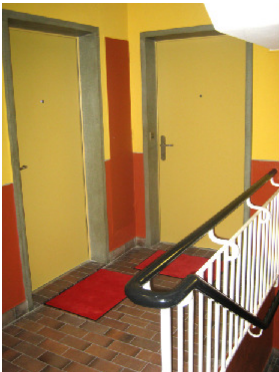
Klinkerboden [+ \delta , - \omega ]. Klosbachstr. 88, 8032 Zürich (1937)
